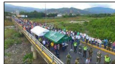
Puente Internacional Simón Bolívar
